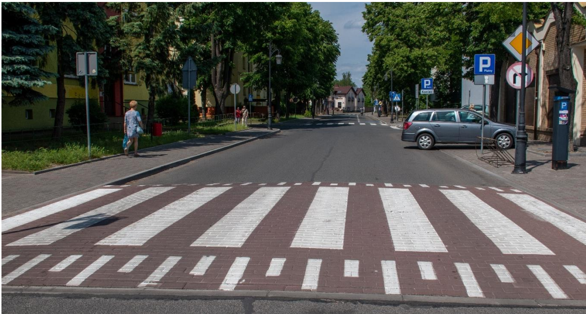
Fotografia 4. Przejście dla pieszych na ul. Strażackiej
